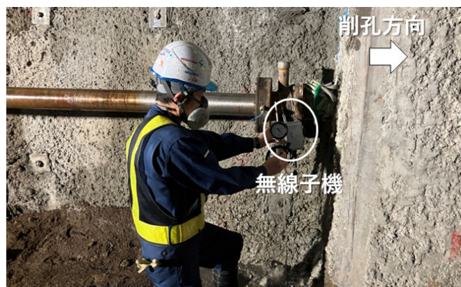
写真-2 無線機器の設置状況
