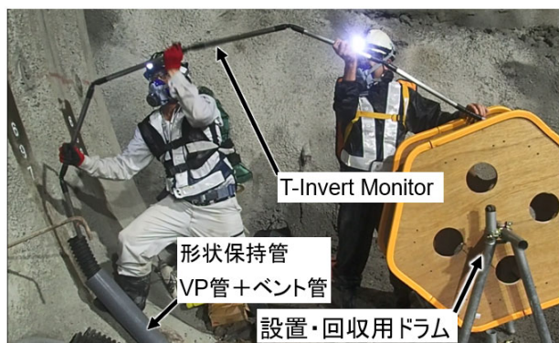
図-12 T-Invert Monitor の挿入状況
