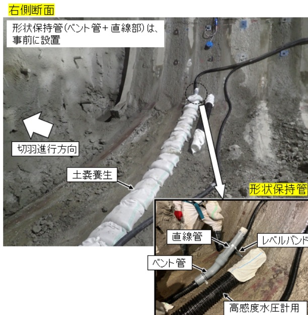
図-11 計測ガイド管の土嚢養生と形状保持管
