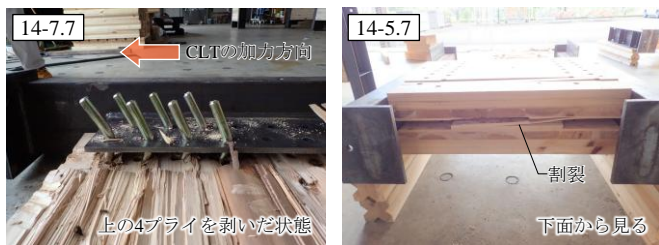
写真-4 ドリフトピン接合部の破壊性状 Photo.4 Failure behavior of drift pins joint
