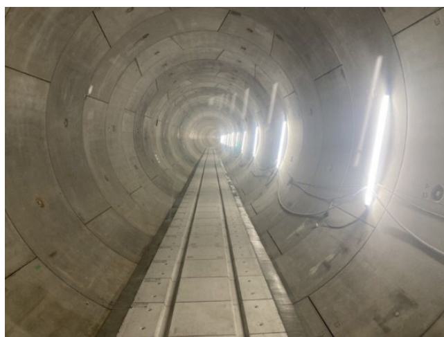
写真-11 セメント・ゼロ型の現場設置状況 Photo.11 On-site installation status of Cement-zero type
