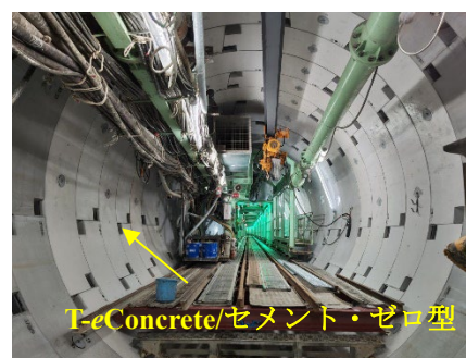
写真-1 セメント・ゼロ型の現場展開製品 Photo.1 On-site application status of cement-zero type
