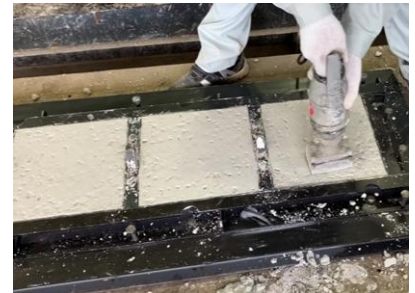
(3)パイプレートによる締固め
