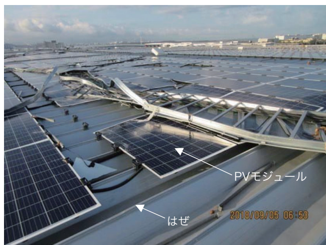
折板屋根(折板で葺いた陸屋根)に設置された太陽光発電設備の強風被害事例[出典:経済産業省, 第14回新エネルギー発電設備事故対応・構造強度WG 資料1]
