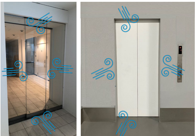
写真-1 低層階にて自動扉およびエレベータ扉へ流入する気流のイメージ
