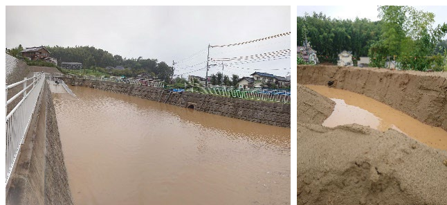
(a) 調整池への集水 (b) 仮排水路
