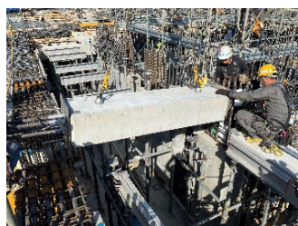
写真-5 境界梁 PCa 部材取り付け状況
