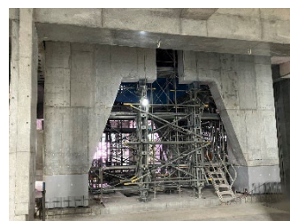
写真-3 壁脚部 PCa 部材設置状況
