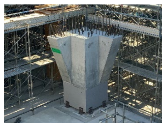
写真-3 壁脚部 PCa 部材設置状況
