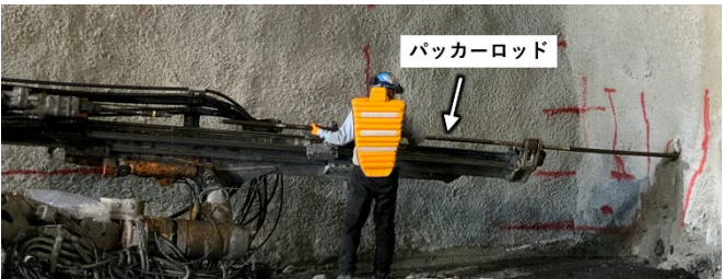
写真-3 パッカーロッド継ぎ足しの様子 Photo.3 Status of rod extension
