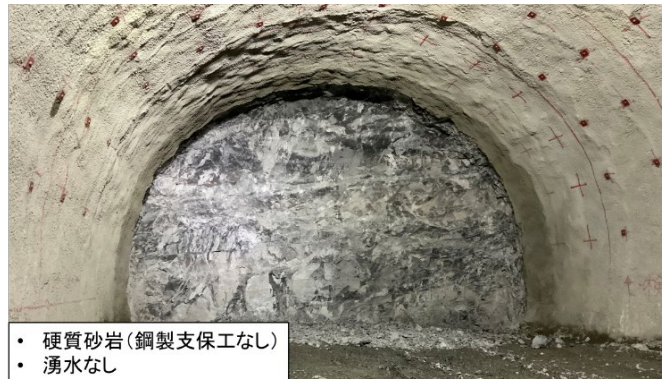
写真-1 試験前の切羽状況
