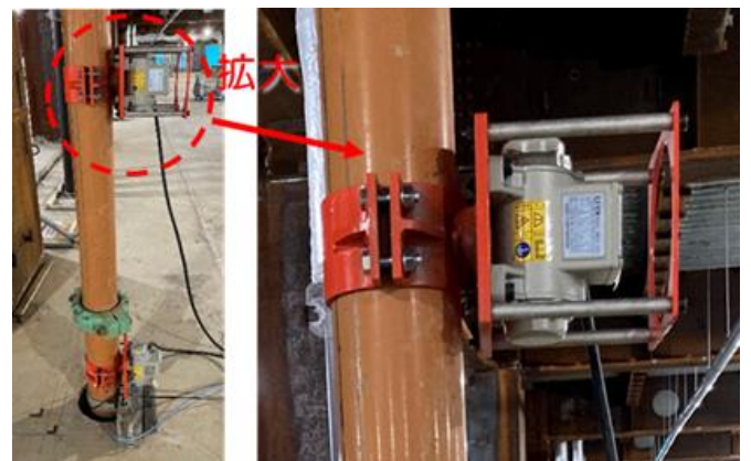
写真-2 バイブレータ取付状況
