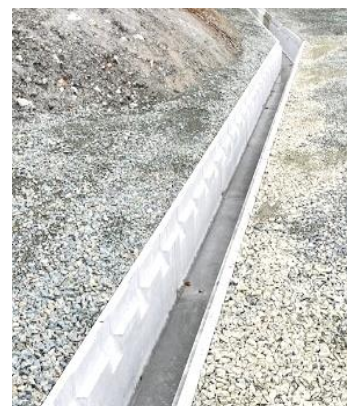
写真-4 落蓋式 U 形側溝 現場設置状況
