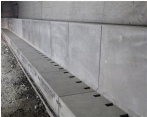
写真-6 縦壁付矩形水路 現場設置状況
