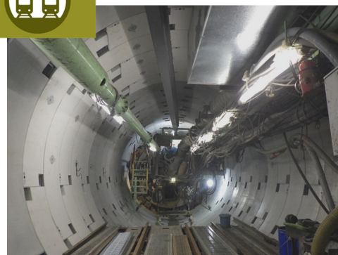
写真-8 シールドトンネル用合成セグメント Photo.8 Shielded tunnel composite segments
