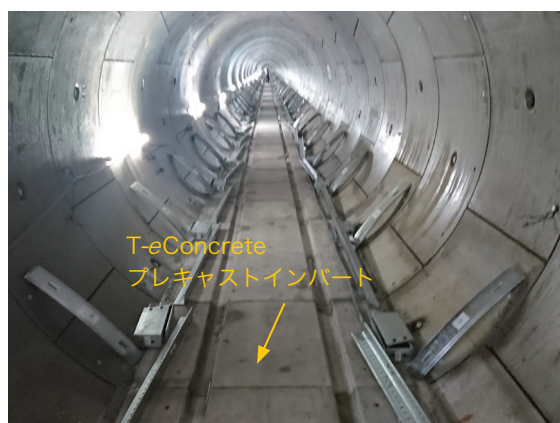
T-eConcrete PCaインバートブロック
