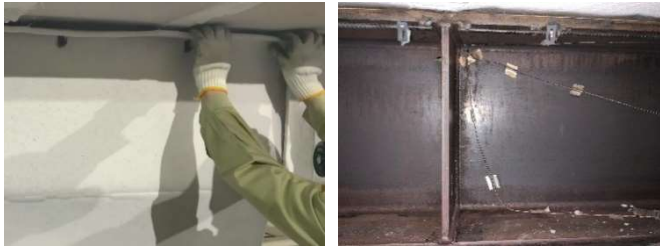
写真-11 試験体解体時の様子 Photo.11 Disassembling of the Specimen
