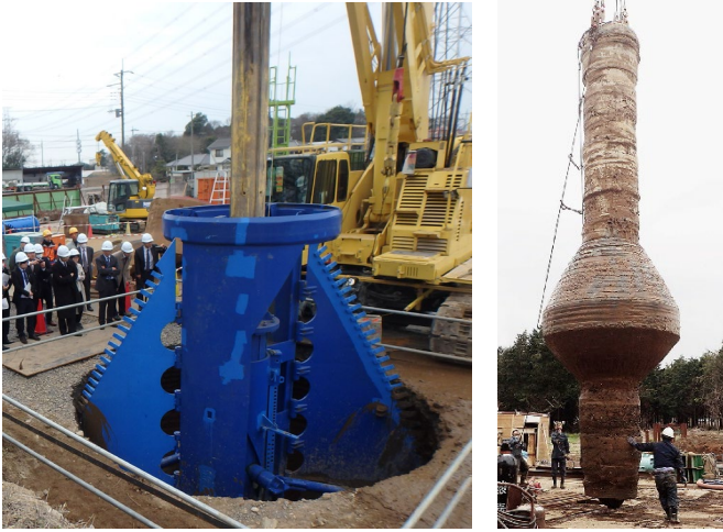
(a) 表層での掘削試験 (b) 杭の掘出し
