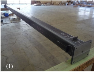
(1) 鉄骨製作工場で作成した角形鋼管部材を 集成材加工工場へ搬入
