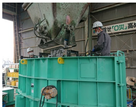
写真-7 打込み状況 Photo. 7 Casting situation
