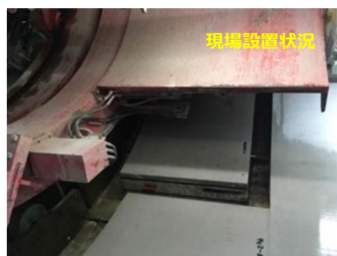
写真-6 現場設置状況 Photo. 6 On-site installation status
