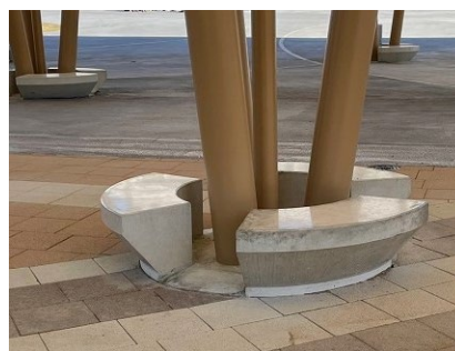
写真-9 コンクリートベンチ 施工完了状況 Photo.9 Completion image of concrete bench
