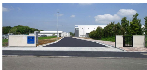
写真-11 門塀 施工完了状況
