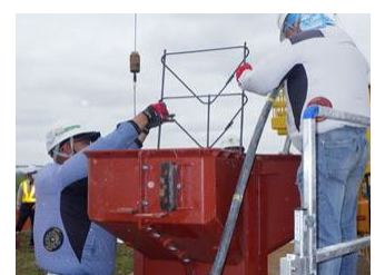
d) 鉄筋挿入
