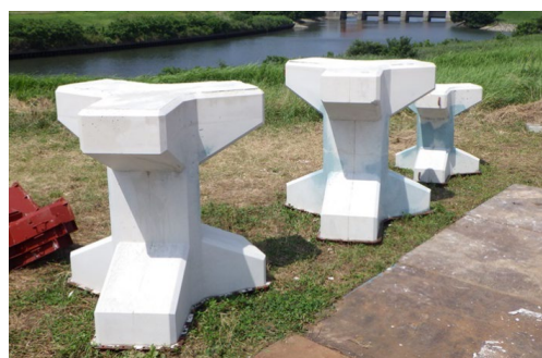
写真-4 根固めブロック 施工完了状況 Photo.4 Completion image of concrete block
