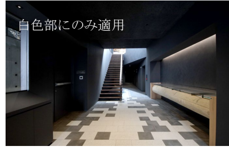
写真-7 内装床仕上げ材 施工完了状況 Photo.7 Completion image of interior concrete floor
