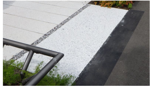
a) 舗装コンクリート全体
