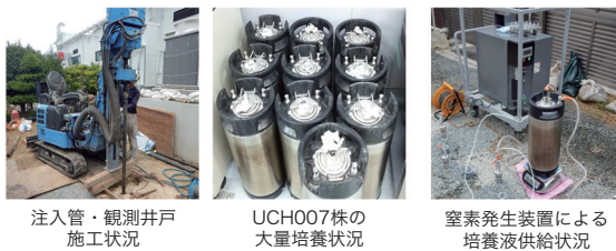
Dehalococcoides属細菌を汚染帯水層に導入する浄化手順
