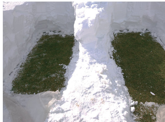
ファブリックヒーター稼働2ヶ月後の状況 (2022年2月16日)
