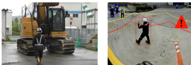
写真-4 バックホウ適応の実証試験状況(左)と検知状況(右) 注2)
