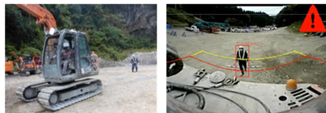
写真-7 バイバック適応の実証試験状況(左)と検知状況(右) 注2)
