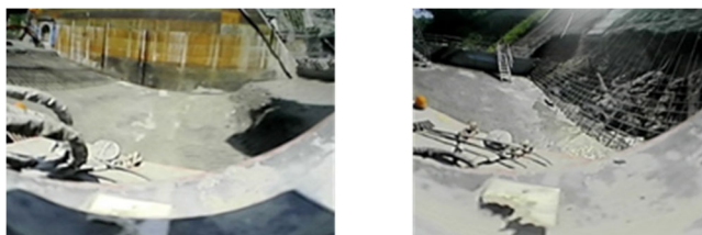
写真-5 第2象限の撮影データ 固定カメラ (左右両方)
