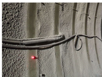
(b) 防護パイプによる養生状況
