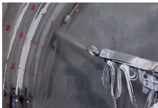
(d) 吹付けコンクリートの施工状況
