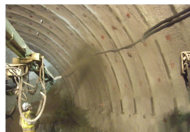
(c) 吹付けコンクリートによる防護工の施工状況
