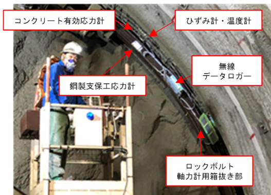
写真-6 計測器設置状況
