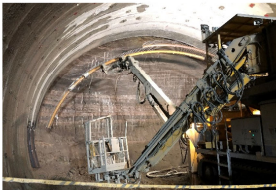
(c) 支保工建て込み並びに計測器設置状況
