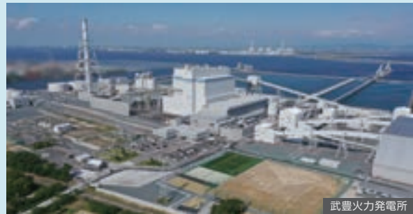
武豊火力発電所
