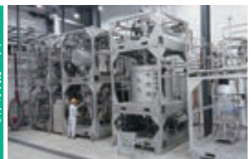
株式会社高砂ケミカル iFactory建設工事 (静岡県掛川市) 発注者：株高砂ケミカル
