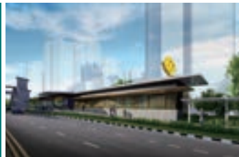
クロスアイランド線-プンゴル分岐線P103工区 (シンガポール共和国) 発注者：シンガポール政府・陸上交通庁(LTA)
