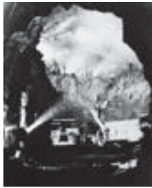
関西電力黒部川第4発電所 (第5工区)
