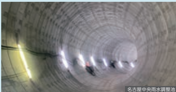
名古屋中央雨水調整池
