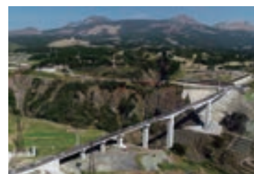
国道325号 新阿蘇大橋
