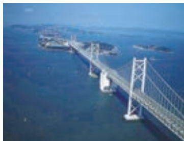
南北備讃瀬戸大橋 (下部工、北工区)
