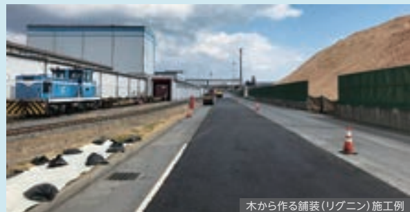
木から作る舗装(リグニン)施工例
