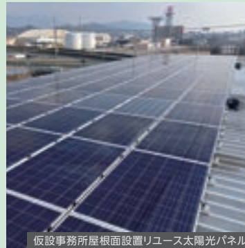
仮設事務所屋根面設置リユース太陽光パネル
