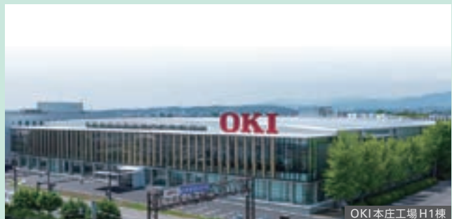
OKI本庄工場H1棟
