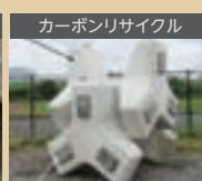
カーボンリサイクル 根固めブロック 荒川右岸堤防 国土交通省関東地方整備局
