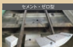
セメント・ゼロ型 歩床ブロック インパットブロック 千葉県印西エリア洞道新設工事(その2) 発注者: 東京電力パワーグリッド(株)
