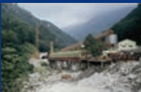
上越新幹線大清水トンネル
