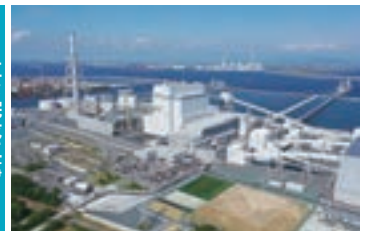
武豊火力発電所5号機 土木建築工事 (愛知県知多郡) 発注者：JERA/パワー武豊合同会社
