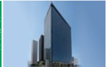
西新宿五丁目北地区防災街区整備事業に係る 施設建築物新築工事(東京都新宿区) 発注者：西新宿五丁目北地区防災街区整備事業組合
