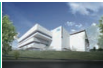
東京エレクトロン宮城株式会社第3開発棟 (宮城県黒川郡大和町) 発注者：東京エレクトロン宮城株
