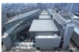
東京国際フォーラム ホール棟
