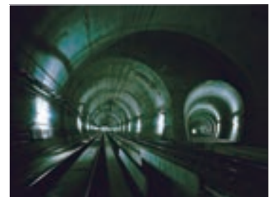
青函トンネル (吉岡工区)
