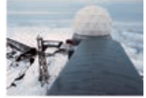
富士山測候所レーダー基地
