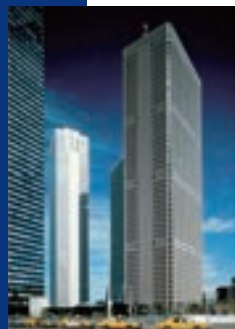
新宿センタービル
