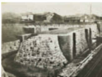
琵琶湖疏水閘門
