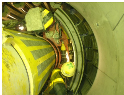
掘進速度同調エレクターによる セグメント組立状況
