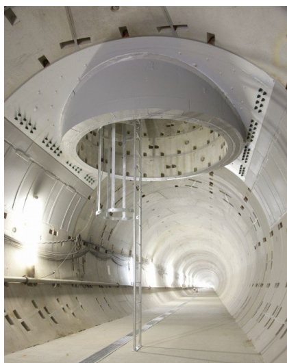
上向きシールド工法で施工した共同溝の立坑接続部
