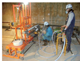
PHb ドリルによる削孔
