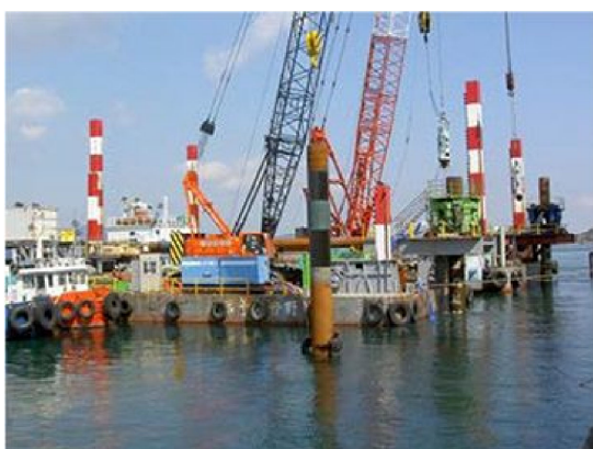
2. 鋼管杭建込み、根固め
