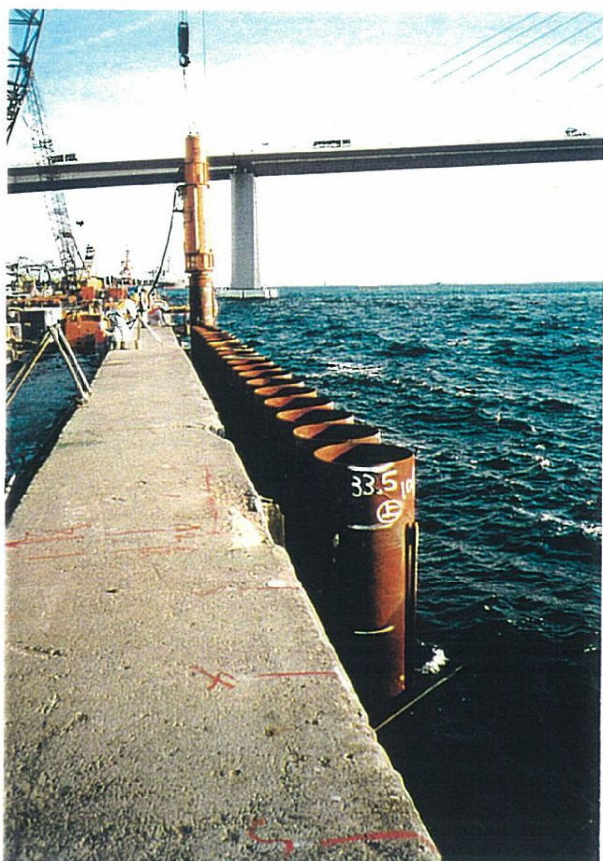
鋼管矢板打設
