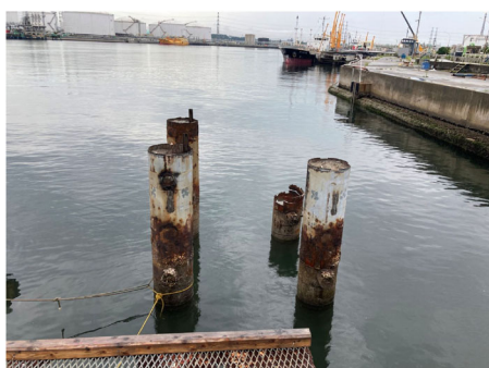
上部工撤去完了
