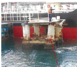
既設既設杭 ドルフィンの損傷状況
