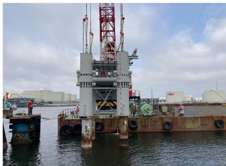
起重機船による据付（webカメラで挿管状況を確認）
