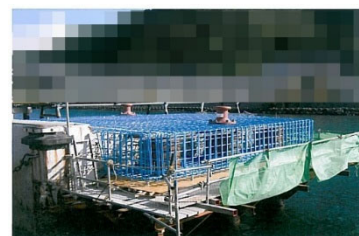
上部工配筋完了
