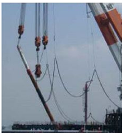
2. 鋼管杭の打設
