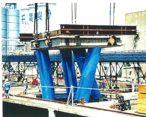
2. テンプレートの挿入・据付
