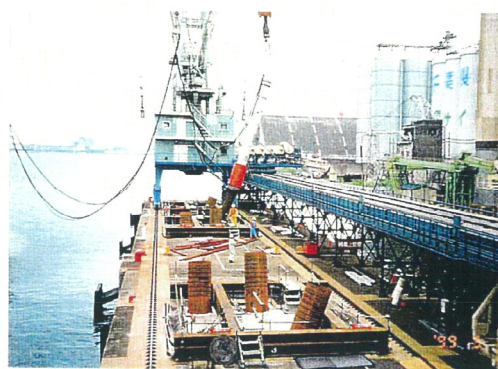
3. 油圧ハンマーによる鋼管杭の打設
