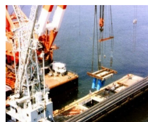
起重機船による上部工架設
