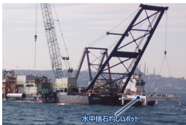
施工状況（装置の構成）
