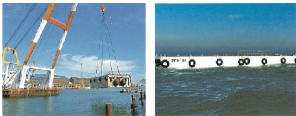
函体着水・ジョイント状況
