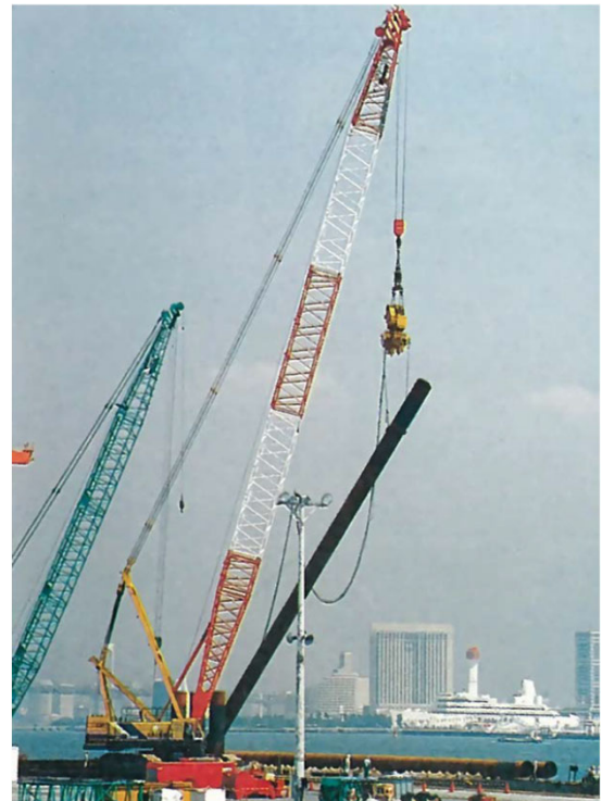
バイブロハンマー鋼管杭同時吊込み状況
