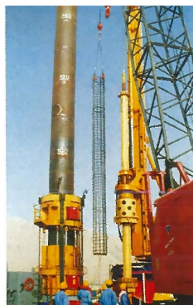
鉄筋かご挿入状況
