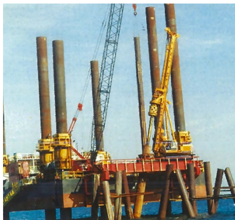
杭内部掘削状況
