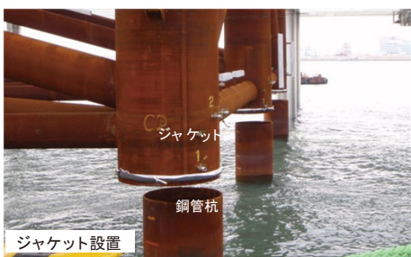
ジャケット工法施工状況
