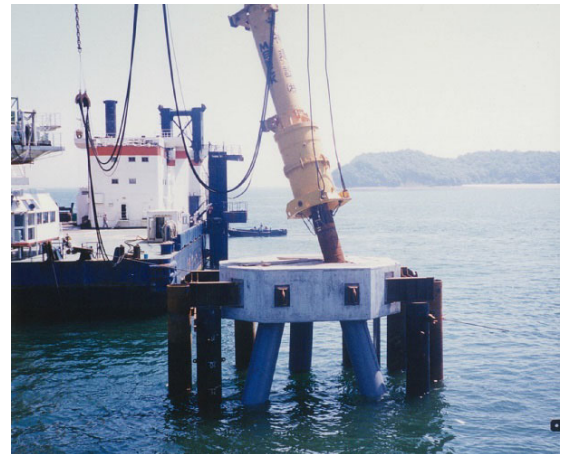
プレキャストコンクリート上部工 （杭打設前にPCa上部工を設置する方法）
