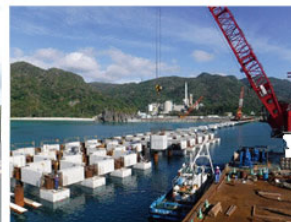
プレキャストコンクリート上部工施工の流れ （杭打設後にPCa上部工を設置する方法）
