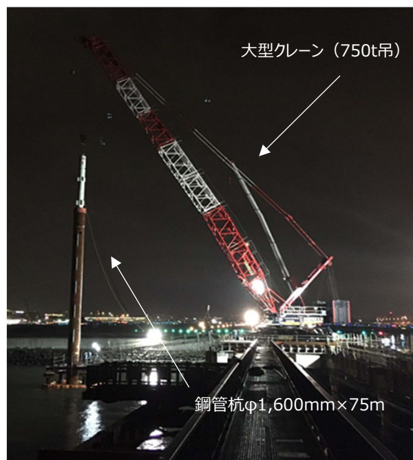
杭打設状況 (750t吊クレーン)
