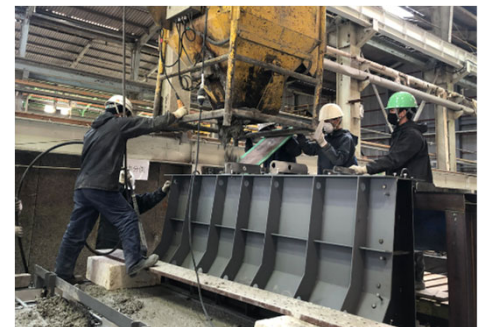
壁高欄一体型の施工状況
