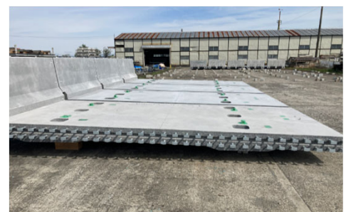
北市場高架橋 壁高欄一体型のPC床版
