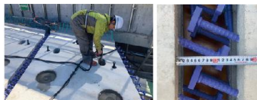
九州自動車道思川橋（上り線）， 2023（斜角のある床版の接合）
