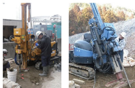
打込み施工状況(鉛直、斜め)
