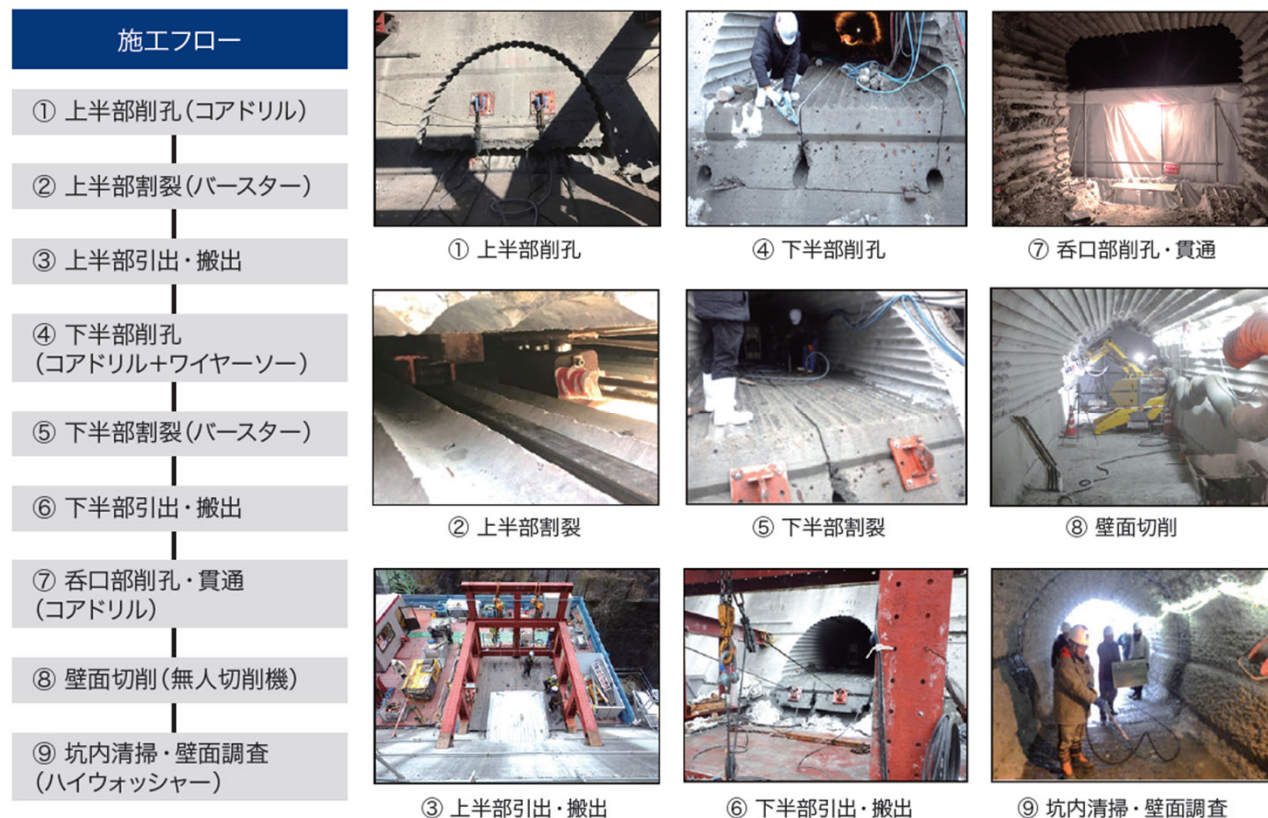
無振動大ブロック分割引出工法 施工フロー
