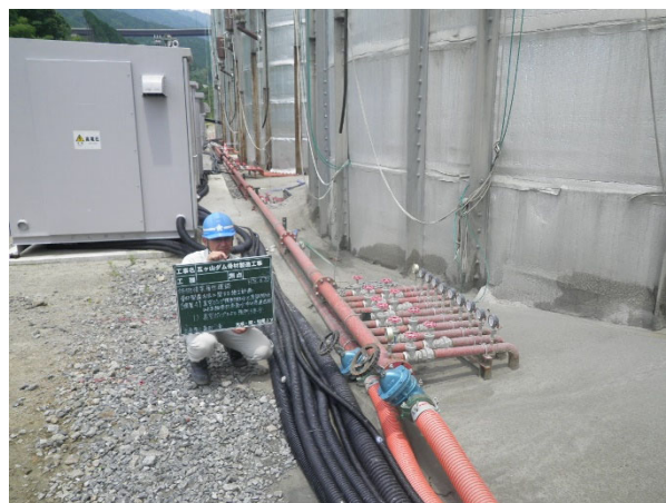
骨材ビン外部：真空ポンプ吸引用ストレーナー管
