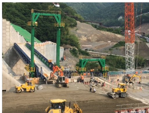
リフトアップ°栈橋による施工状況
