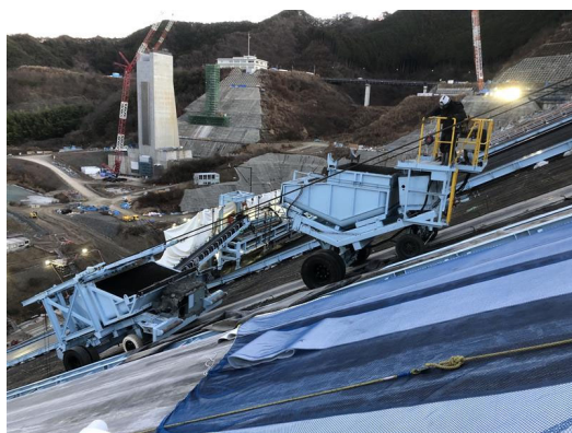
ダンパー車によるコンクリート運搬
