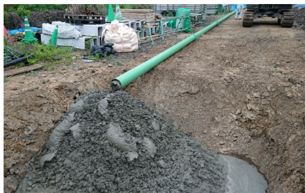
ポンプによるコンクリート圧送状況
