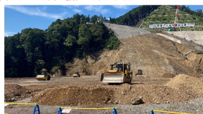
2022年3月より 関東支店南摩ダム本体工事作業所で自動建機4台の協調運転を実施
