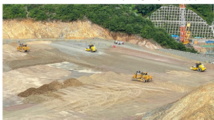
2022年3月より 関東支店南摩ダム本体工事作業所で自動建機4台の協調運転を実施
